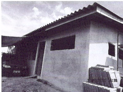
Figura 2 - 16/01/2019 - Cobertura, vista lateral
