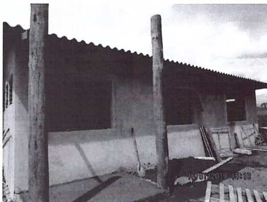
Figura 5 - 16/01/2019 - Vista das aberturas das janelas
