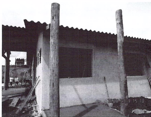
Figura 6 - 16/01/2019 - Vista das aberturas das janelas
